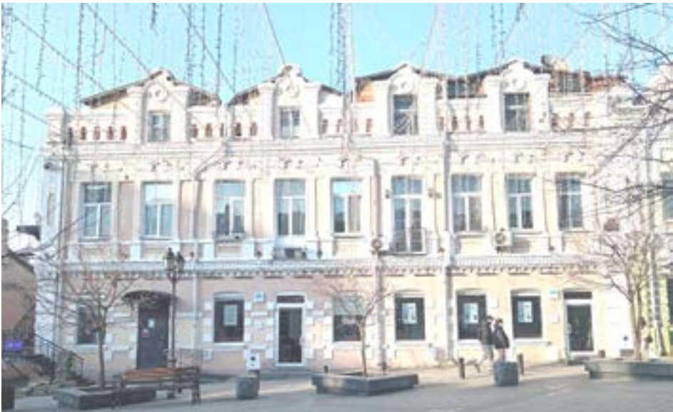
Главный (южный) фасад
