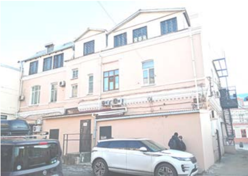
Дворовой (восточный) фасад
