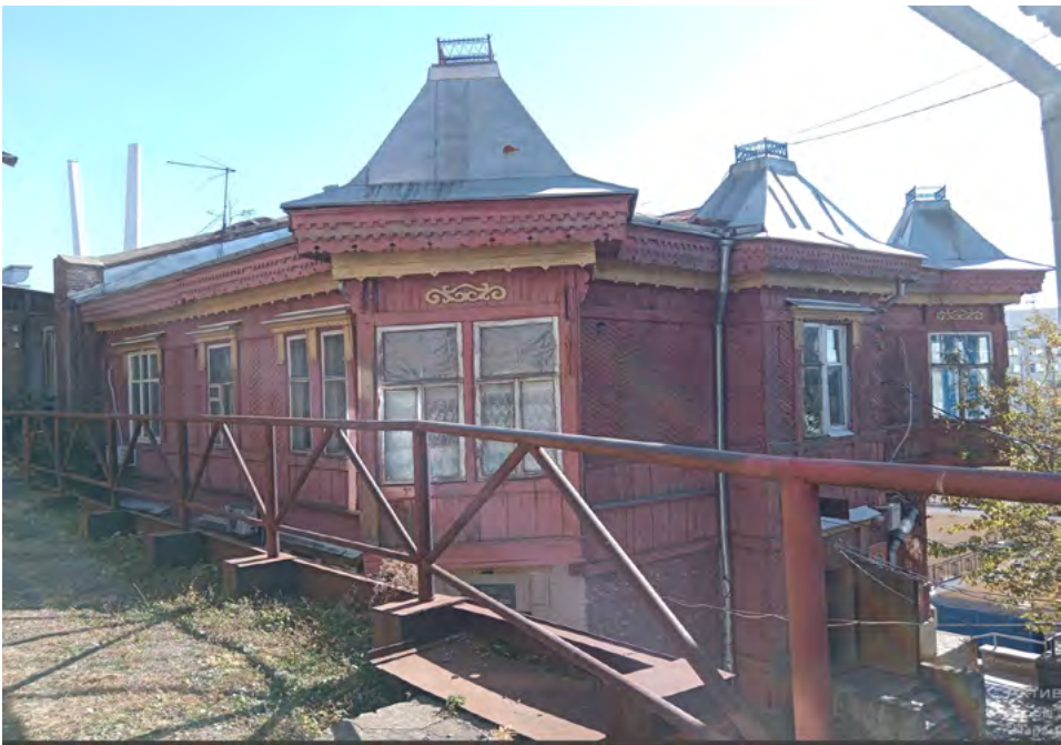
Западный и северный фасады
