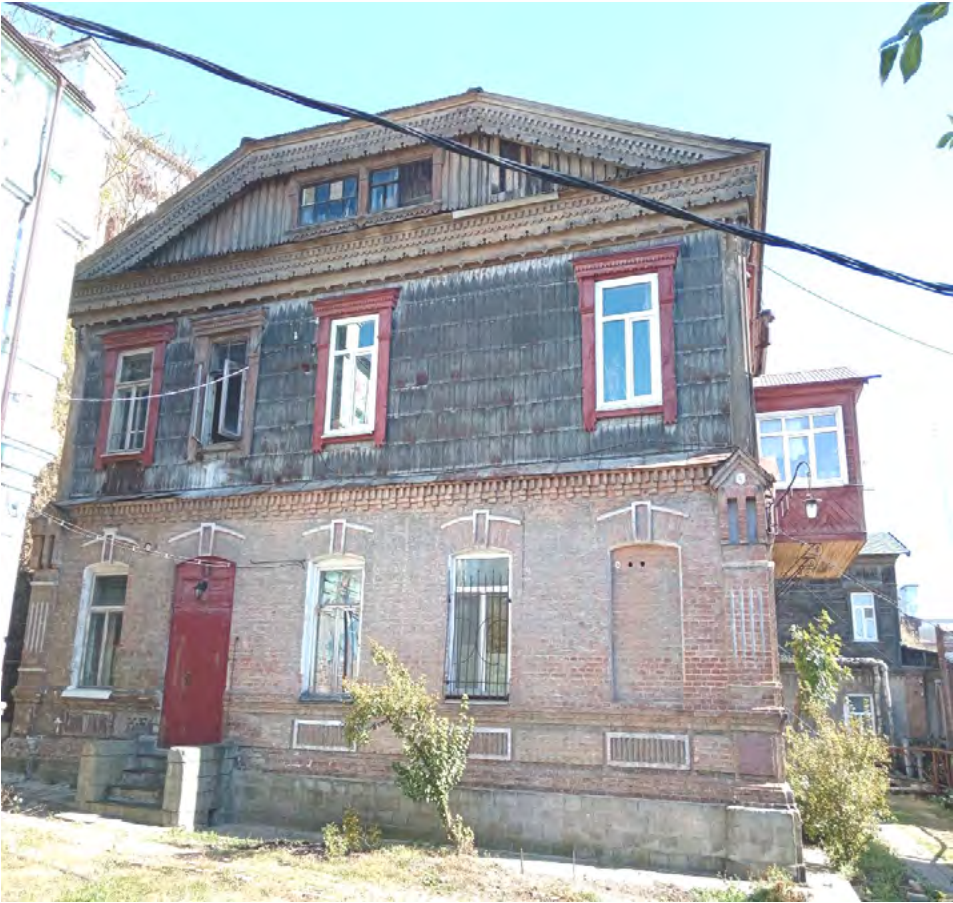
Западный фасад здания (ул. Светланская 39а)
