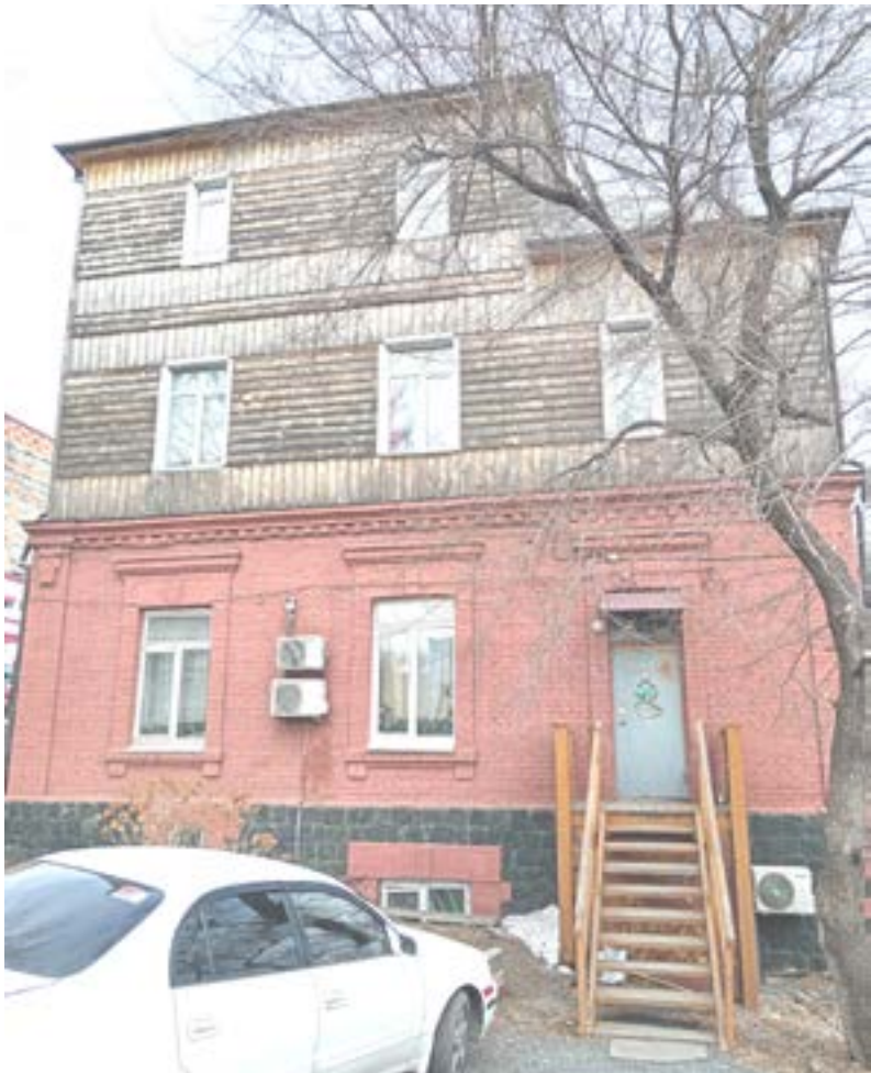
Торцевой (юго-западный) фасад
