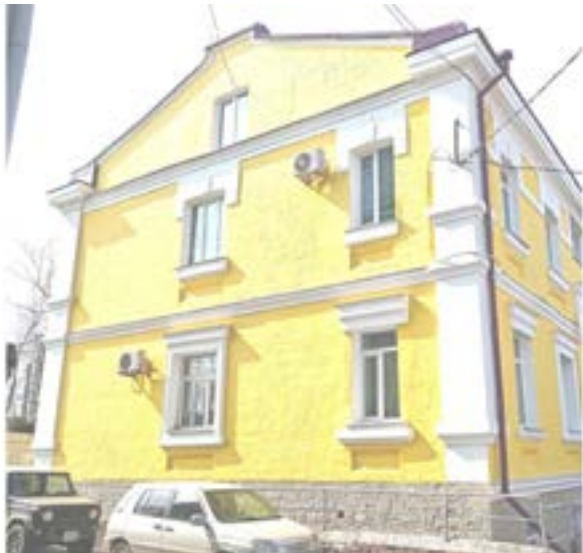
Торцевой западный фасад
