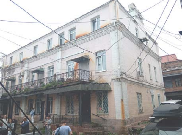
Общий вид с юго-запада
