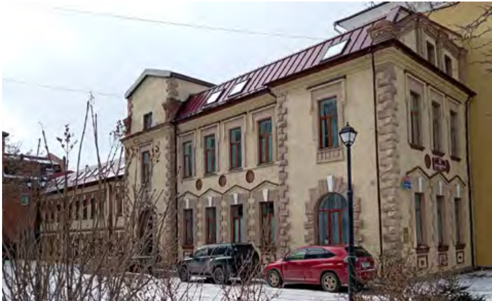
3. Композиция и архитектурно-художественное решение фасадов Объект культурного наследия построен в рациональном «кирпичном» стиле. Декоративные элементы выполнены с помощью напуска кирпича. Главный (восточный) фасад здания Асимметричное общее композиционное решение образовано сочетанием плоскостей фасадных поверхностей двух строительных объёмов со сдвижкой в пол этажа. Симметричное композиционное решение правой части фасада сформировано незначительно выступающими из плоскости фасада двумя одноосными ризалитами и четырехосным простенком с равномерно расположенными оконными проемами прямоугольной формы. Асимметричное композиционное решение левой части фасада сформировано простенками, разделенными плоскими лопатками, с ритмичным расположением оконных проемов прямоугольной формы.
