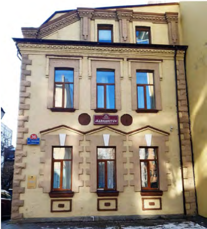
- оформление прямоугольных оконных проемов первого этажа с клинчатыми перемычками, украшенными выступающими замковыми камнями, рустованными наличниками и двухступенчатыми подоконными карнизами; - прямоугольные подоконные накладками в уровне первого этажа, имитирующие ниши с горизонтальными прямоугольными накладками в центре; - двухступенчатые треугольные сандрики над оконными проемами 1 этажа; - оформление оконных проемов второго этажа прямоугольной формы с клинчатыми перемычками простыми прямоугольными двухступенчатыми сандриками, плоскими П-образными наличниками, обрамленными по краям висячими накладками и двухступенчатыми подоконными карнизами; - две плоские круглые ниши, расположенные под междуоконными простенками второго этажа фиксирующие главную композиционную ось фасада; - многоступенчатый венчающий карниз, украшенный поясом сухарей; - угловой парапетный столбик, завершенный ступенчатым карнизом; - три лопатки с висячими накладками завершенные, выступающими из плоскости венчающего карниза аттика, многоступенчатыми карнизами; - два прямоугольных оконных проема стены аттикового этажа с простыми плоскими П-образными наличниками; - многоступенчатый венчающий карниз аттикового этажа, украшенный поясом сухарей.
