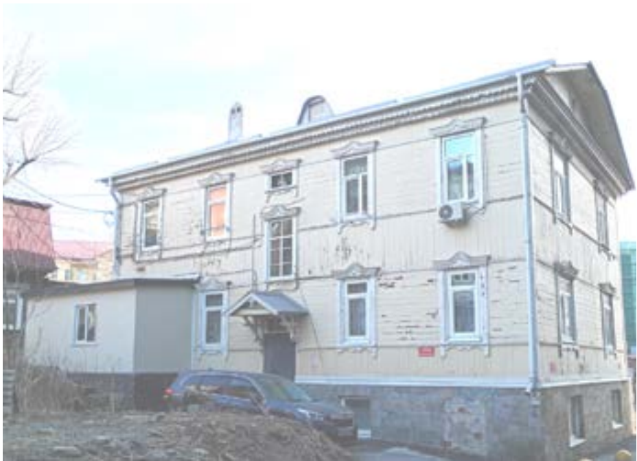
Двухэтажный прямоугольный объём под скатной крышей.
